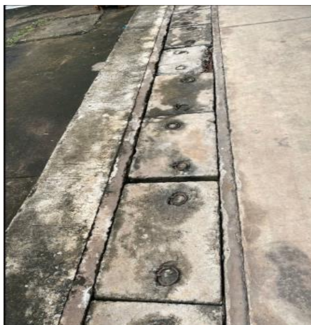
Mương thu gom, thoát nước mưa
